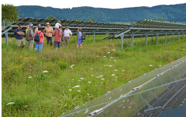
写真 2-1 モースホーフ・ソーラーパークの草原 17ha 出力 4.5MWの太陽光発電施設 (©solarcomplex AG)
