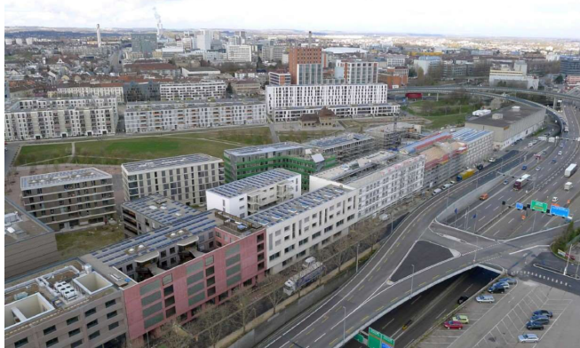
写真 2-4 建設協同組合式で、屋根全面に 850kW の発電所を作り、電気・熱を供給】
